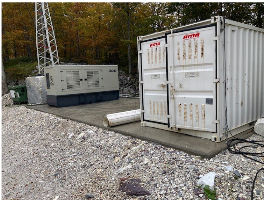
Fig. 4- piazzola in cemento per generatore e container con cisterna del gasolio
